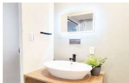
ベッセルタイプ洗面台造作(写真は施工例です)
