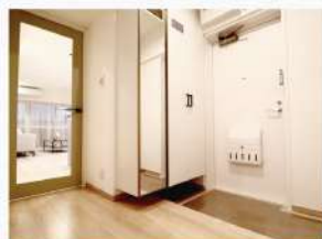
玄関収納新規取付
